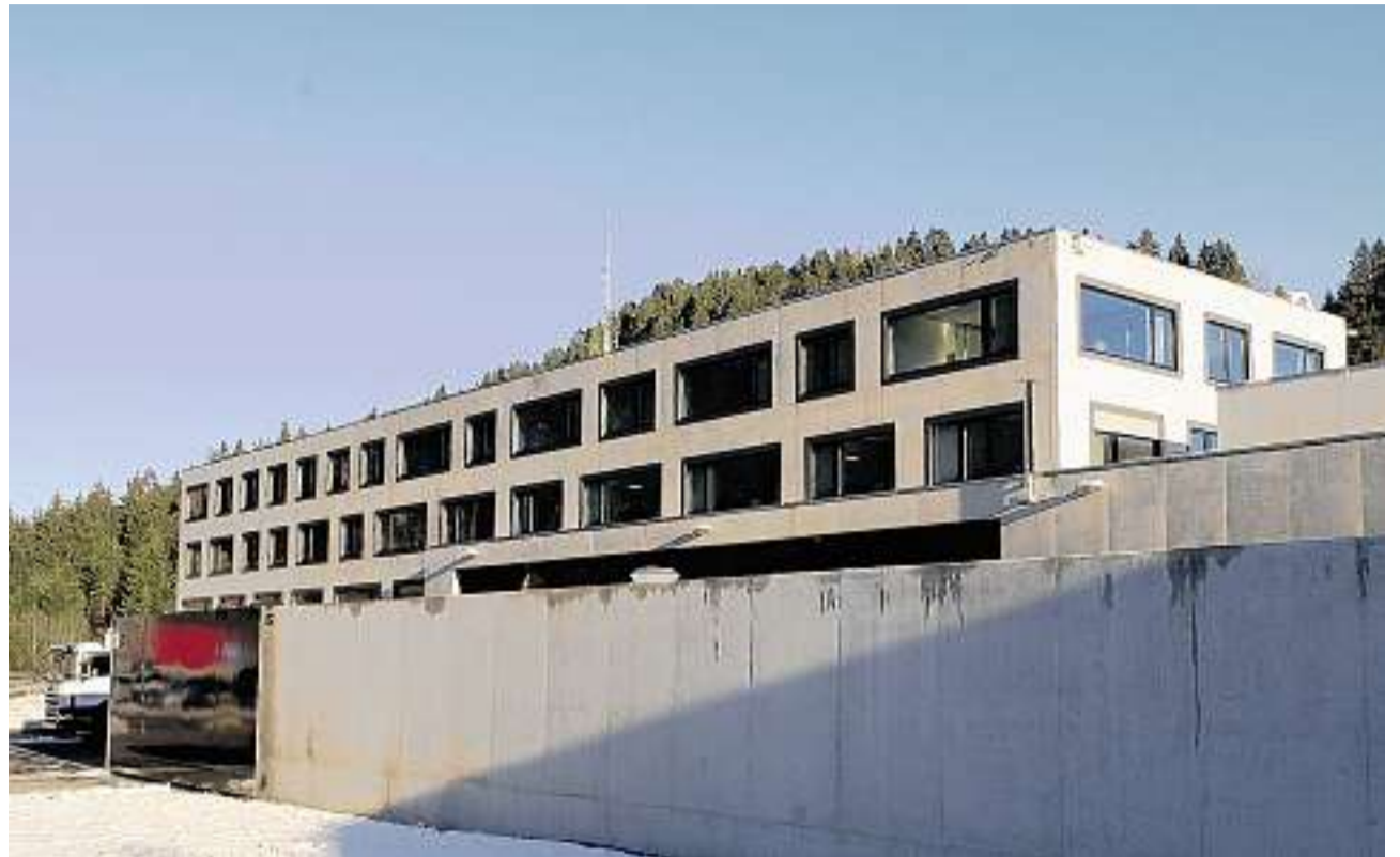
Die Arbeit wurde aufgenommen: Vermutlich auf Neujahr wird der neue Sicherheitsstützpunkt in Biberbrugg voll betriebsbereit sein.
