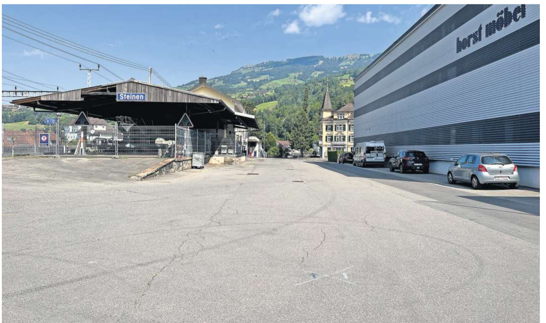
Die Rampe an der Südseite des Steiner Bahnhofs wird teilweise abgebrochen, um die Buswendeschleife zu realisieren.
