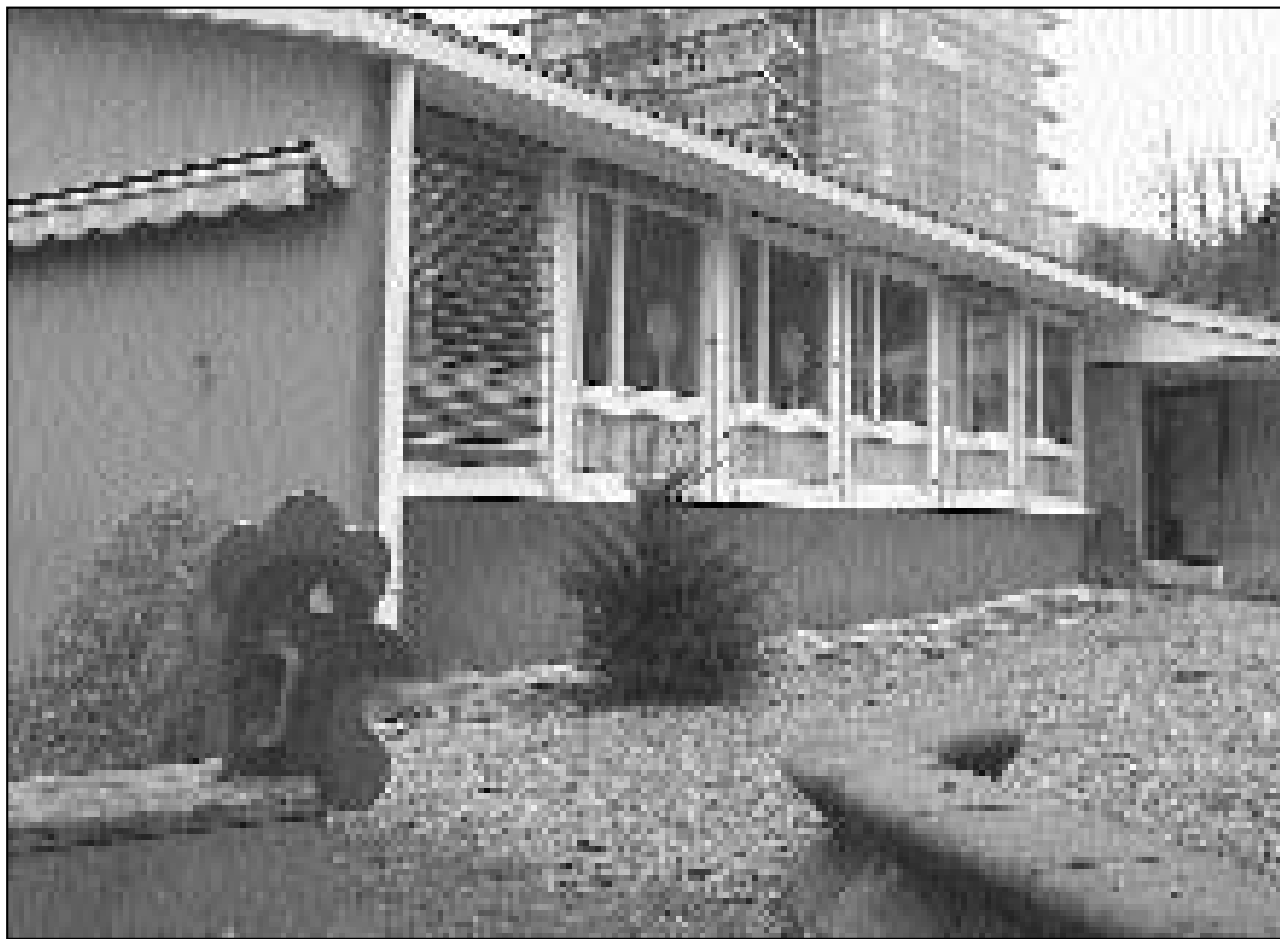
Der Kindergarten am Mühlemoosweg in Oberarth soll für 510 000 Franken saniert werden.
