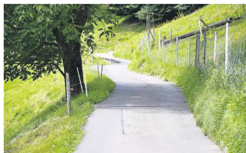
Die talseitige Fahrbahnhälfte musste infolge Rutschung und Senkung schon mehrfach mit Belag überbaut werden. Bild: Franz Steinegger
