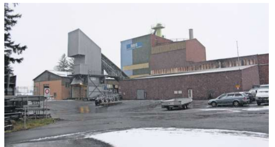
Auf dem Areal der BBS in Seewen bei der Autobahn wird eine Wasserstofftankstelle realisiert. Bild: Christoph Clavadetscher
